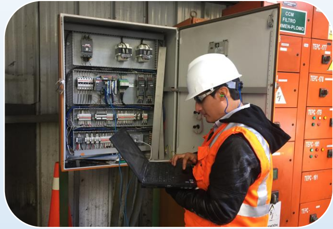
MIGRACIÓN DE SISTEMA DE CONTROL DE ESPESADOR DE PLOMO
